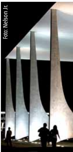
Detalhe lateral do prédio do STF.
