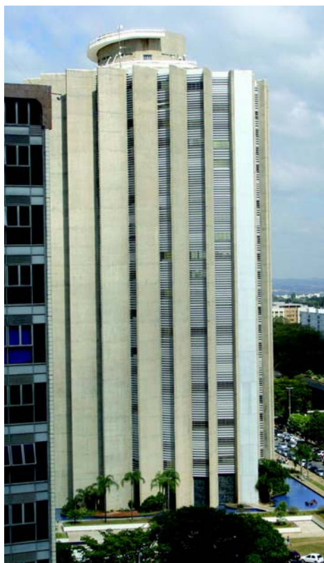
Da nova sede vê-se o prédio da CAIXA...
